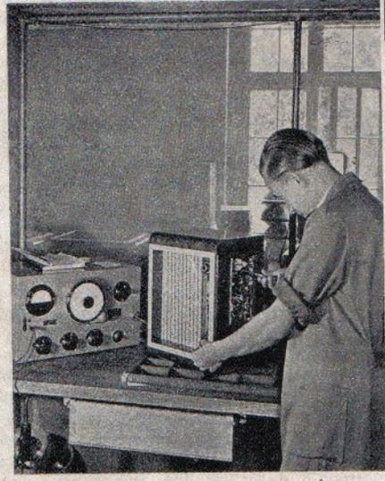
Endkontrolle der Geräte im abgeschirmten Käfig
